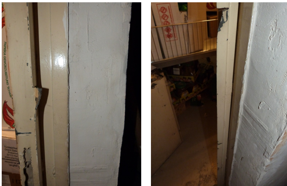
Auf dem linken Lichtbild ist der obere Einschnitt mit der Hebelverformung des Rahmenblechs gut sichtbar; das rechte Lichtbild zeigt auch den unteren Einschnitt in das Rahmenblech.
